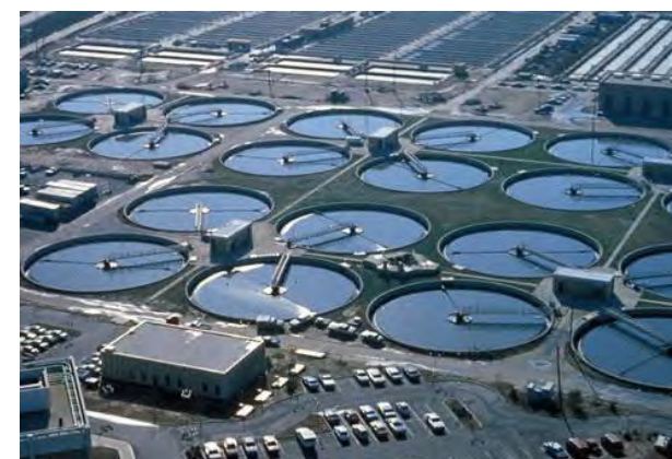
Tratamento de esgoto
